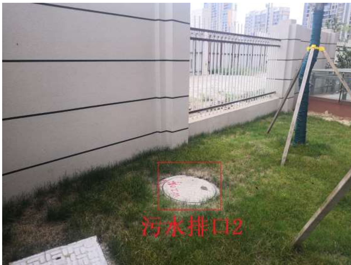
附图四：污水排口 2
