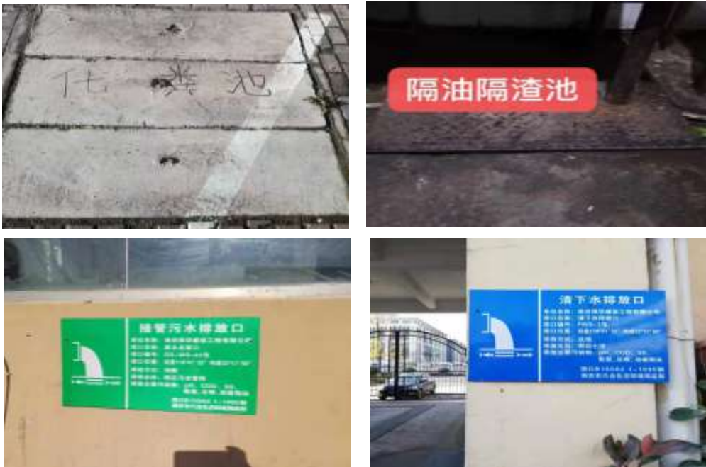
图 4-2 废水处理设施照片
