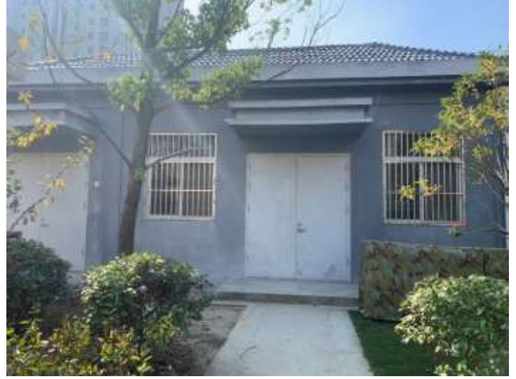
C 地块配电所
