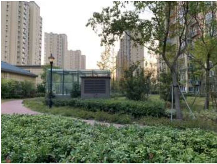
A 地块地下车库排风口
