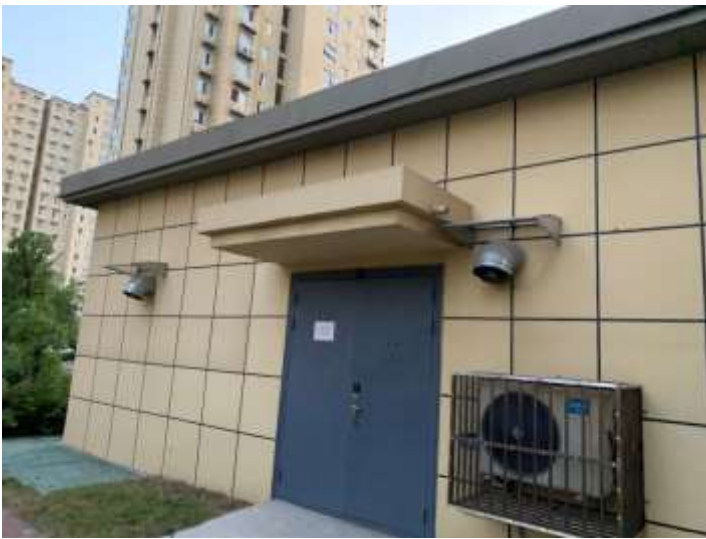
A 地块 2#配电所
