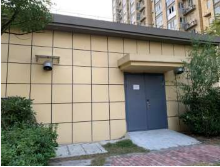
A 地块 4#配电所
