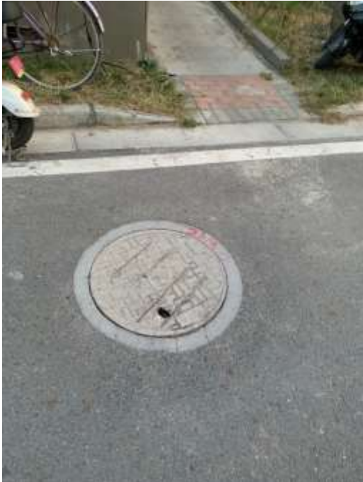
A 地块污水井
