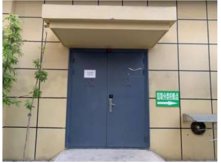
A 地块 1#配电所
