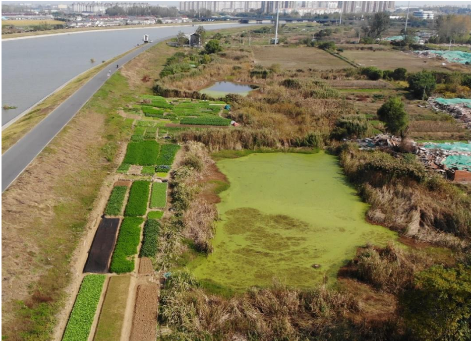
图 1-16 河道工程建设点现场图
