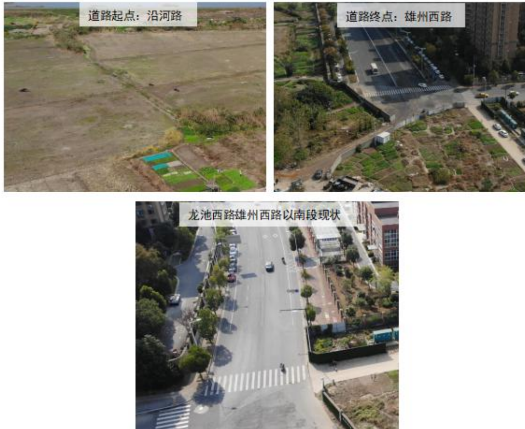
图 1-12 龙池西路起终点现场图
